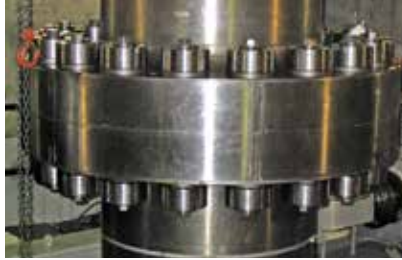
Superbolt dübelli civatalar, burada bir pompa depolama tesisindeki Francis tipi pompa/ jeneratör shaft kaplininde görüldüğü üzere, şaft kaplinlerinde kullanmak için son derece uygundur.
